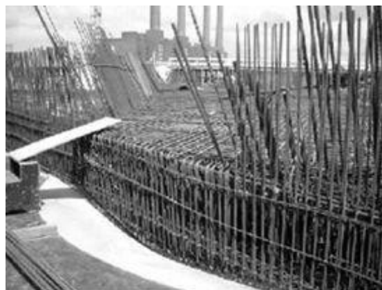
Слика 5 - Густо арматурни склоп, за који је примјењен бетон са додатком "HRWRA"
