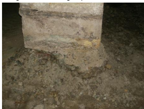
Slika 12. Izgled nosećeg stuba ispod podne ploče
