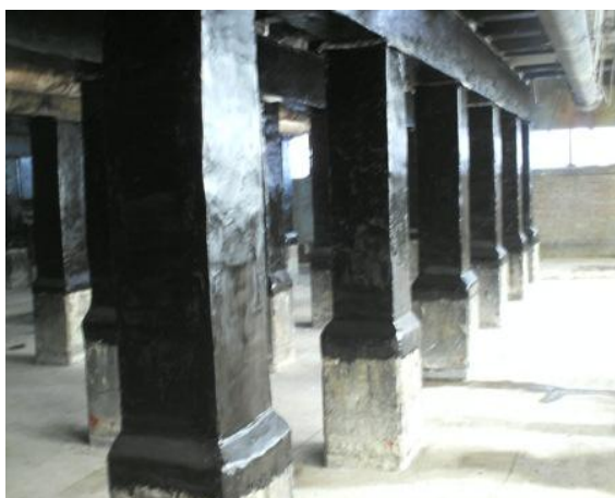
Slika 26. Zaštita greda i stubova "kzs masom"
