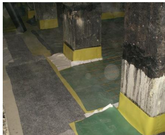
Slika 18. Postavljanje hidroizolacije I
