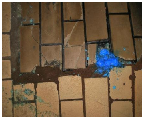
Slika 10. Naprsle pločice usled dejstva kristalizacije bakar-sulfata
