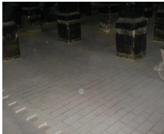
Slika 23. Postavljanje pločica na horizontalnoj površini
