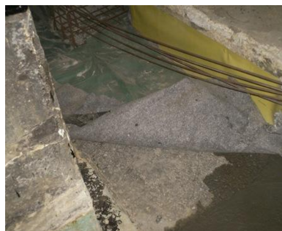
Slika 19. Postavljanje kiseline izolacije
