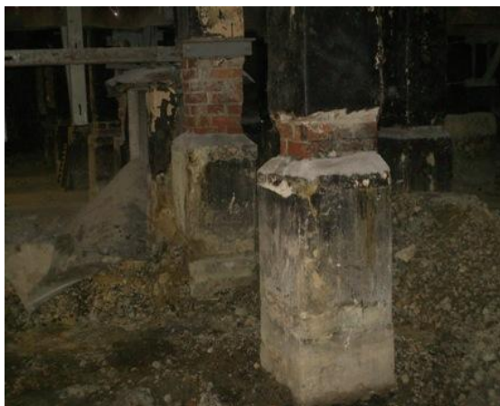
Slika 16. Uklanjanje zakišelenog betona
