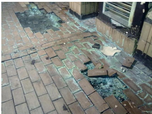
Slika 6. Pucanje pločica pod dejstvom kristalizacije bakar-sulfata
