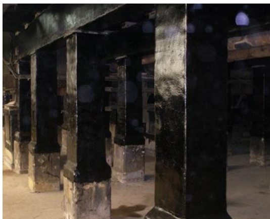
Slika 25. Nanošenje "kzs mase" na noseće stubove
