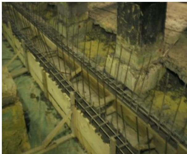
Slika 22. Betoniranje odvodnih kanala
