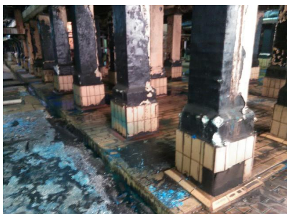
Slika 3. Izgled nosećih stubova nakon dejstva radnog elektrolita
