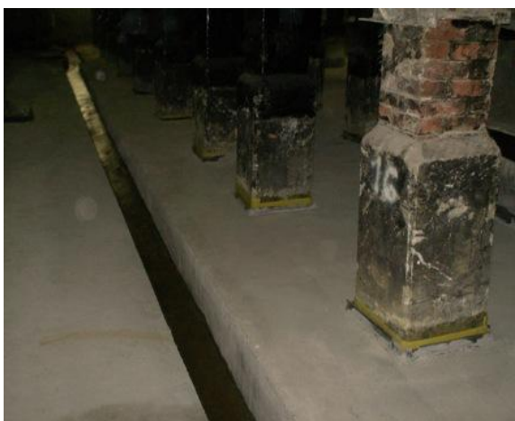
Slika 21. Betoniranje armirano betonske ploče
