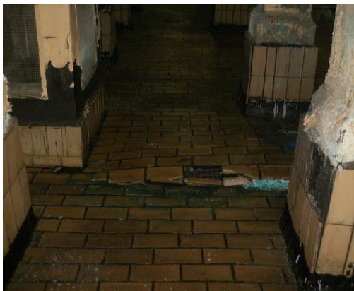
Slika 7. Dejstvo kiselog rastvora bakar(II) sulfata na betonsku površinu
