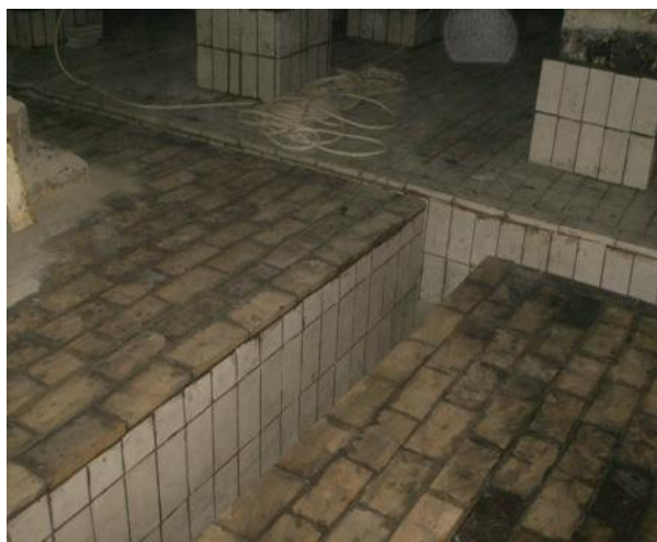
Slika 24. Postavljanje pločica u kanal
